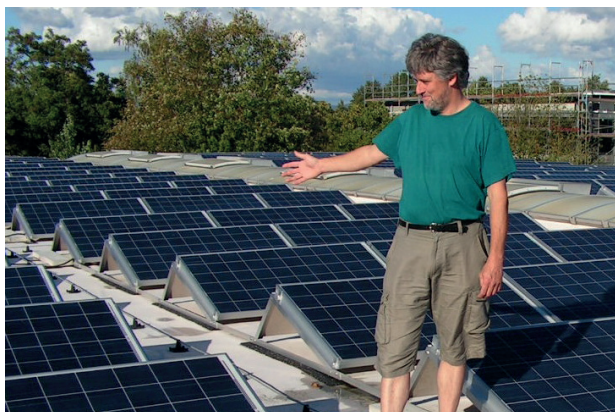
Photovoltaik-Anlage auf der Sporthalle der Realschule im Sommer 2012
